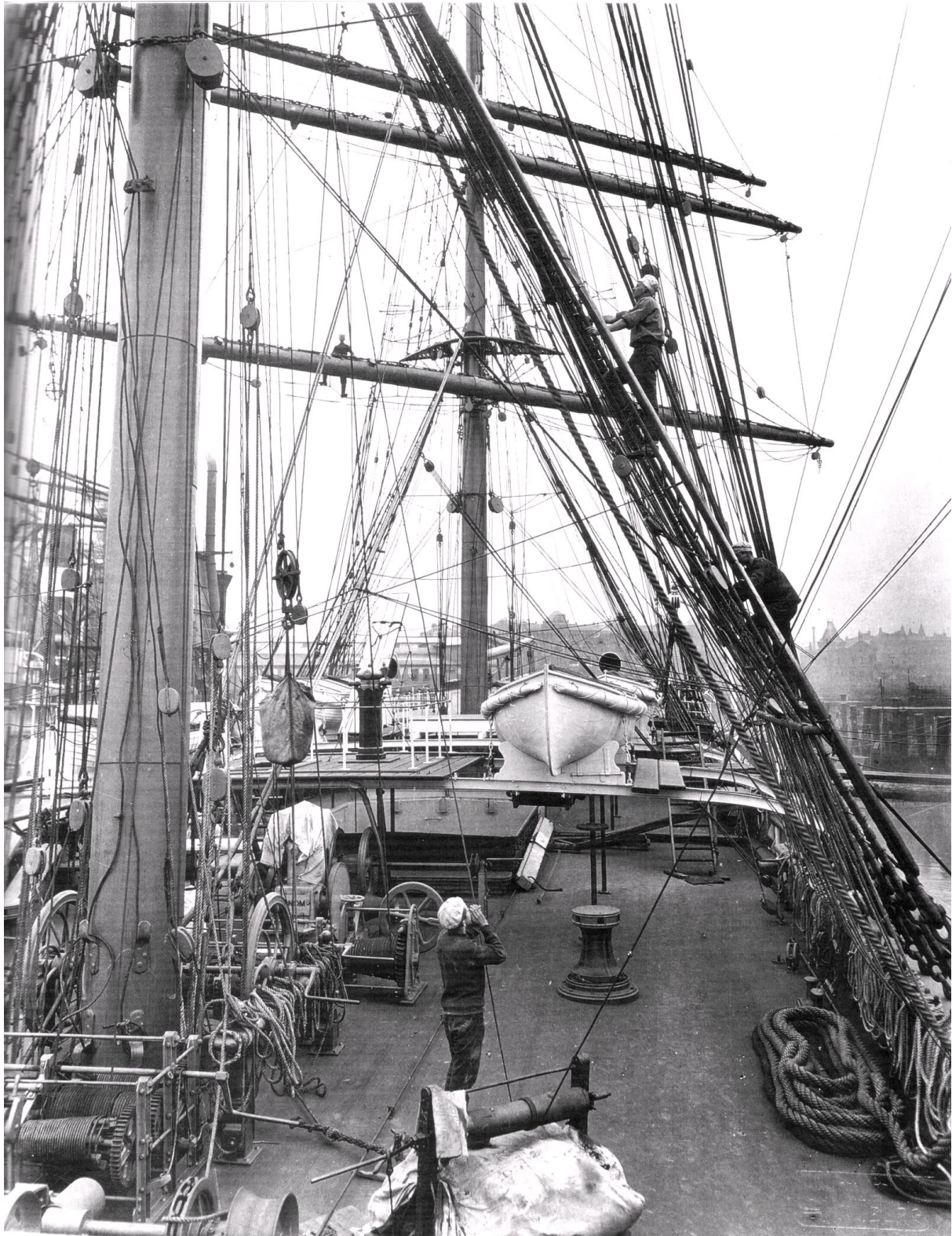
Das Deck am Achtermast (der 4.) des Fünfmastvollschiffs „Preußen“. Hier tummeln sich die Winden: im Vordergrund eine Dampfwinde mit Kettennuß für Transmission, rechts eine provisorisch beschwerte Krüppelwinde (der Klappläufer mit dem Sack schwebt hinter dem Mast), dann (wie hier üblich) vor dem Mast die Brasswinde für die Mittelmastbrassen, dann die Schwungräder der Pumpen, dann (hinter dem Mast) die Brasswinde für den Kreuzmast, eine Fallwinde für die Obermars- oder die Oberbramrah, dann eine Ladewinde (zu oder von der die Kettentransmission führt), vor dem Boot ein Gangspill, und unter den Trägern der Boote hängt noch eine Relingswinde (horizontaler Spillkopf). Einen Schritt hinter dem Rufer läuft das Steuerseil von der Rudermaschine achtern zum Steuerrad auf dem Brückendeck. Die oberen seitlich gut fixierten Umlenklöcke der Unterrah- und Untermarsrahbrassen sind recht tief unter der Saling angebracht, damit sie nicht an den Untermarssschoten (die mit kleinen Blöcken zum Mast geholt werden) schamfilen. Gut zu erkennen auch die nach vorn laufenden unteren Brassen des Kreuzmastes, mit ihrem ungünstigen Zugwinkel. Von den Backbordpardunen (rechts im Vordergrund) laufen über den Unterstag des Kreuzmastes fest angebrachte Seile zu den Steuerbordpardunen (in etwa 4 m Höhe über dem Deck). Diese sollen verhindern, daß das (gerade nicht angeschlagene) Stengestagssegel auf die Boote oder die Säule des Peilkompasses fällt (oder sie hochreißt).
